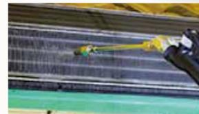
熱交換器のカビやホコリを専用の資器材と薬剤で高圧洗浄します。
